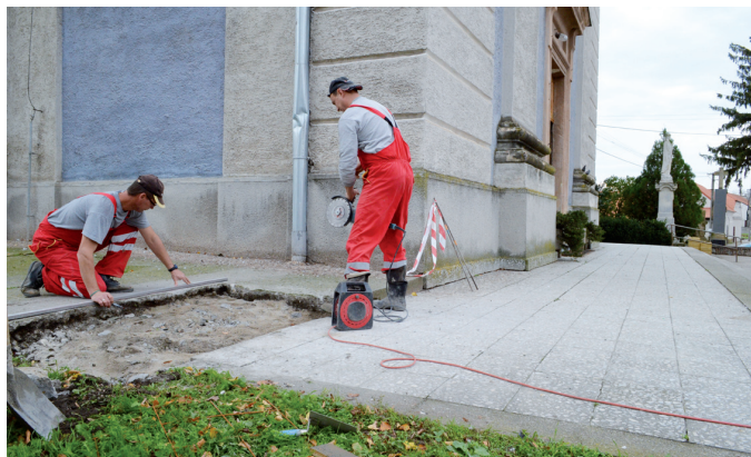
Práce na bezbariérovom prístupe do kostola
