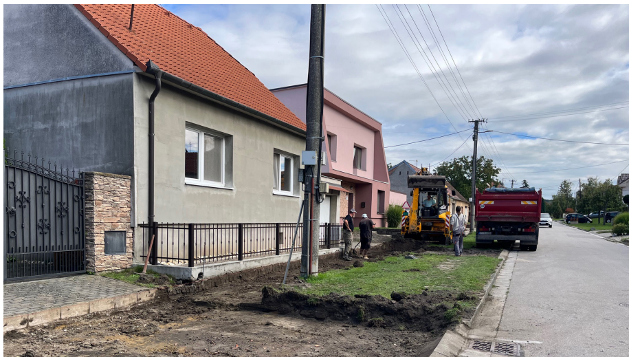
Práce na Štefánikovej ulici
