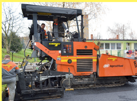
Asfaltovanie cesty k materskej škole
