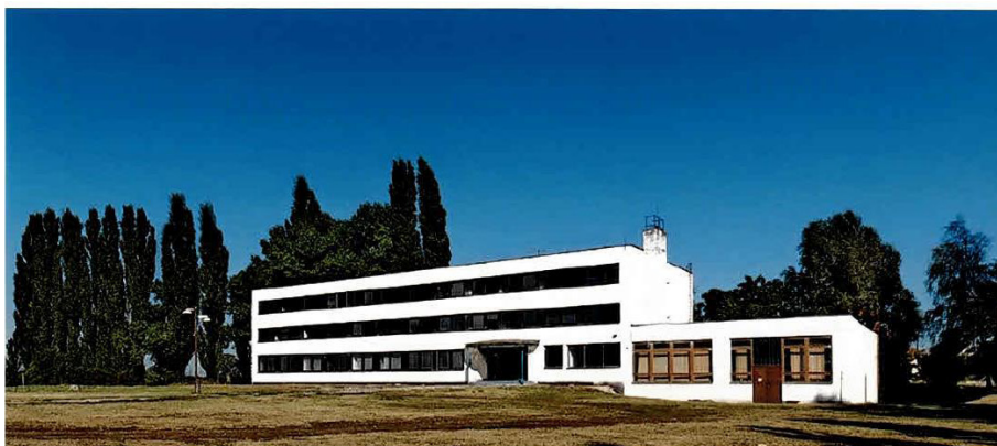
DPS na Hudecovej ulici (pôvodný stav)
