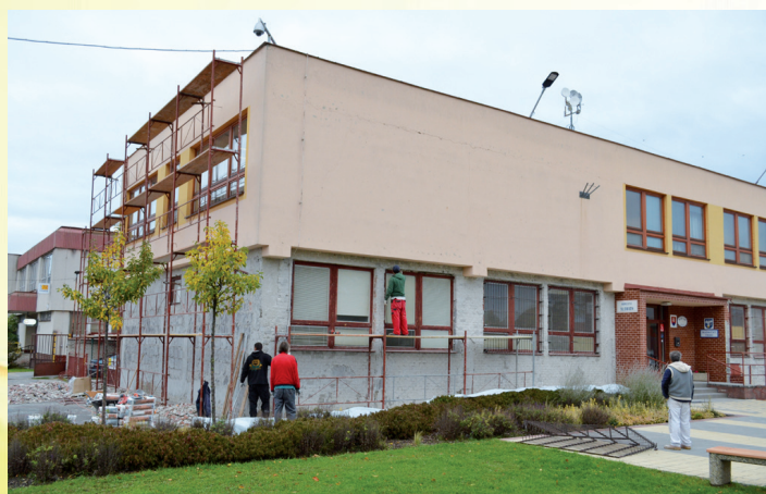
Práce na rekonštrukcii budovy mestského úradu
