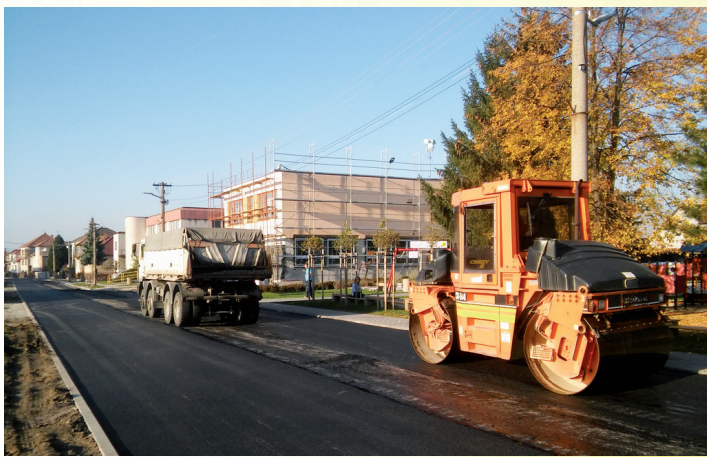
Ulica SNP - asfaltovanie miestnej komunikácie
