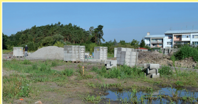
Na ulici Medlenova sa začalo s budovaním základov prvého domu na zakúpených pozemkoch.
