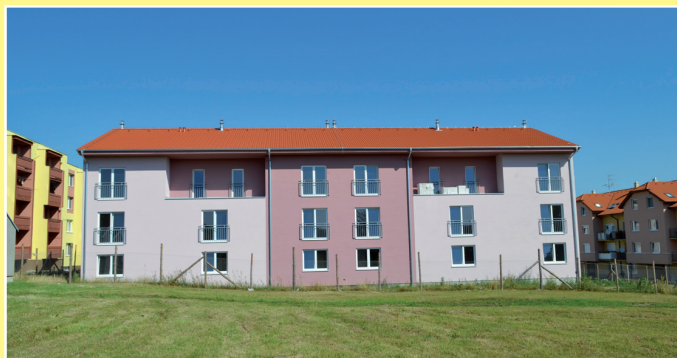
Práce na výstavbe bytového domu pokračujú podľa harmonogramu.
