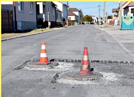
Oprava asfaltového povrchu na ulici ČSĽA
