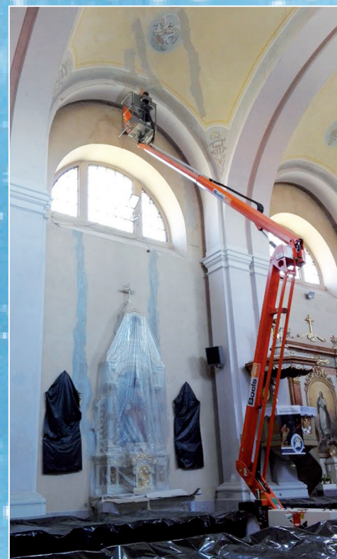
Oprava praskliny v kostole
